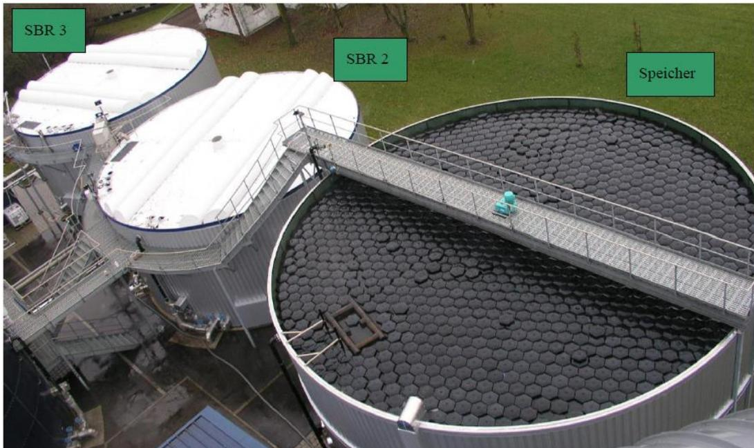
Abbildung 29: Isolierte SBRs 2 und 3, rechts isolierter Speicher mit Schwimmabdeckung (Wagner, 2012)
