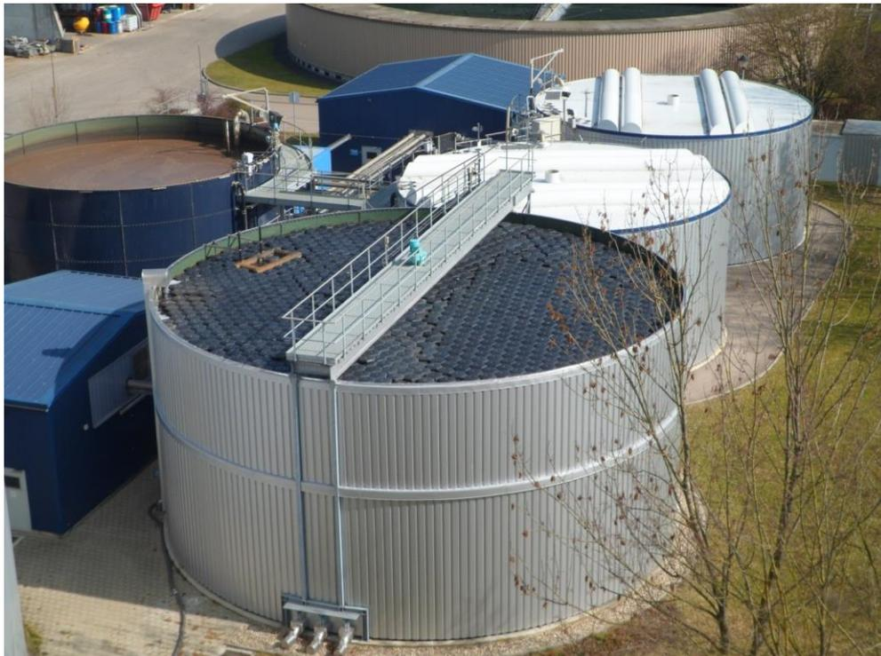
Abbildung 47: Pilotanlage ZKA Ingolstadt, SBR 1 ohne und SBR 2 und 3 mit Wärmedämmung und Abdeckung, vorne : isolierter Speicher mit Schwimmbdeckung
